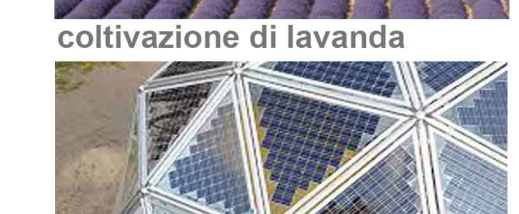
fotovoltaico su geodetica
